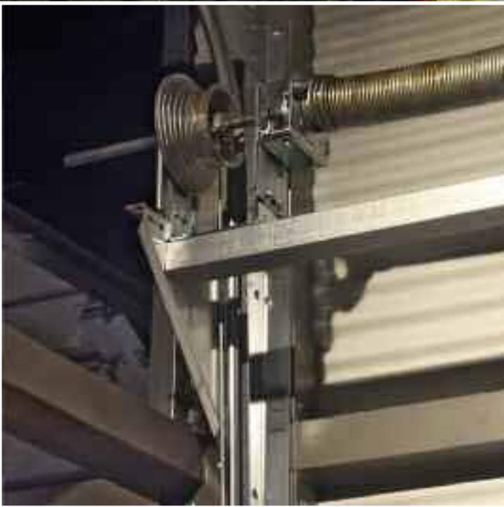
Con el paquete de suspensión rebajado, el montaje y el mantenimiento resultan muy fáciles, porque el sistema está colocado directamente encima de la abertura.
